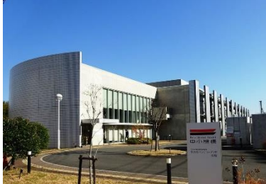
京大桂ベンチャープラザ南館外観
